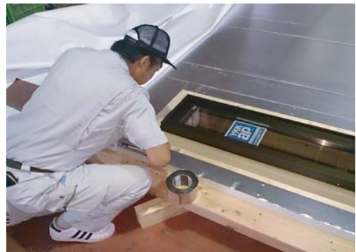
サッシの防水テープ施工
