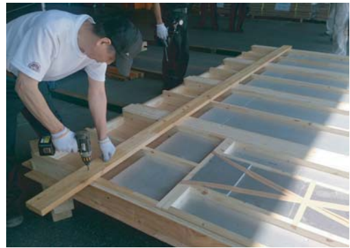
断熱材の張り込み
