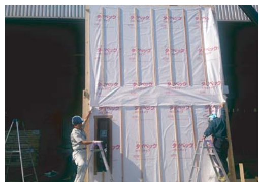
組み立てはクレーンで行い金物で接合します
