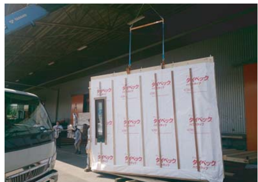
組み立てはクレーンで行い金物で接合します
